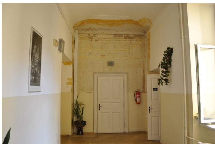
2.NP - chodba před skladem
