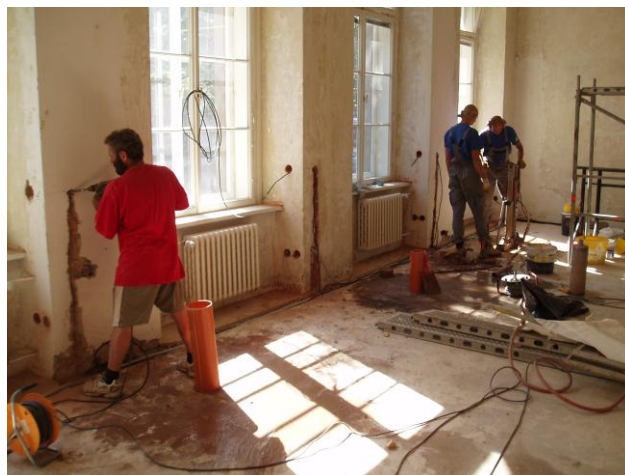
obr. Učebna č. 1 a č. 2 o prázdninách v rekonstrukci na Centrum dentální hygieny
