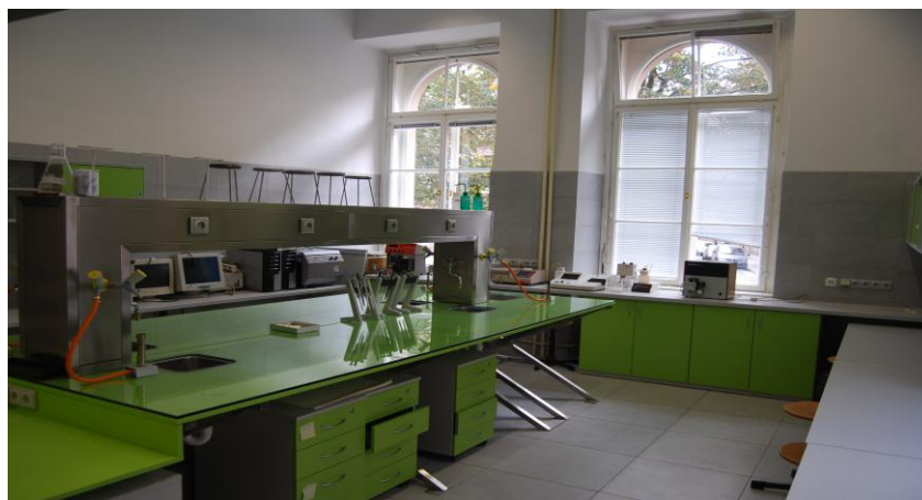
obr. Laboratoře po rekonstrukci - nové rozvody k laboratorním stolům, obklady, dlažby
