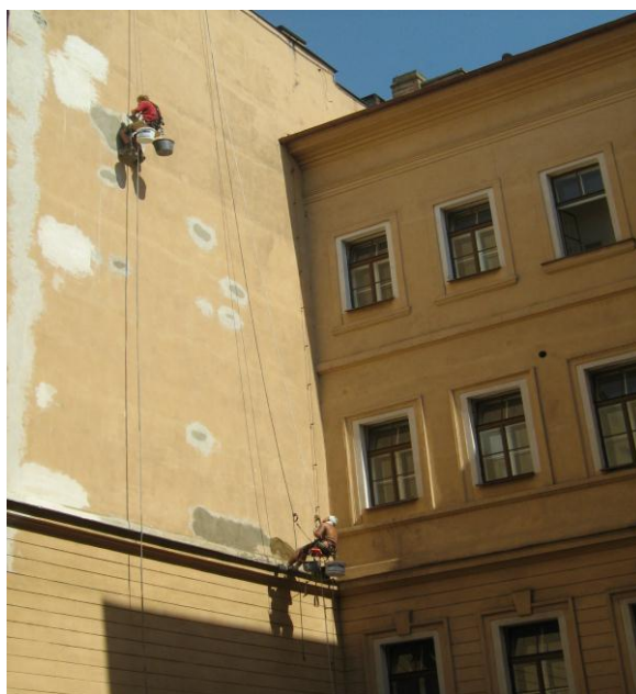
obr. Oprava fasády ve vnitrobloku budovy školy
